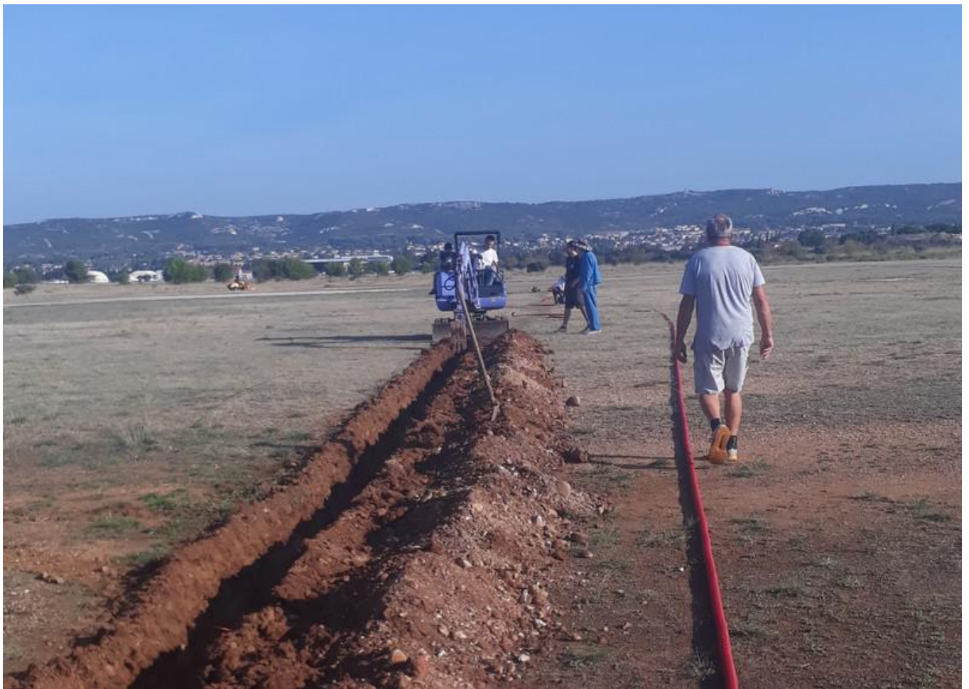
La tranchée est presque terminée, il va falloir y loger la gaine, raccorder les câbles aux deux extrémités, puis la refermer.
