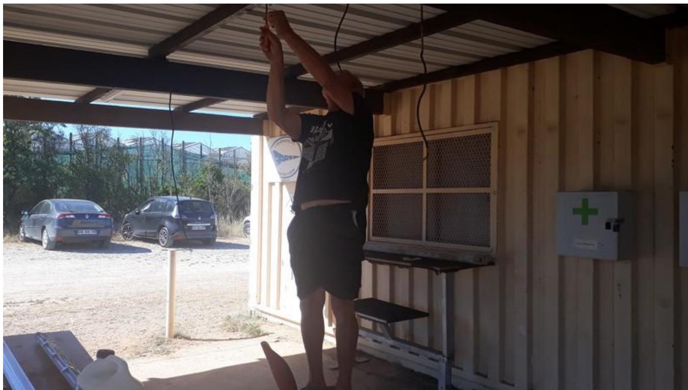
Changement des anciens néons énergivores par de la technologie à LED.
